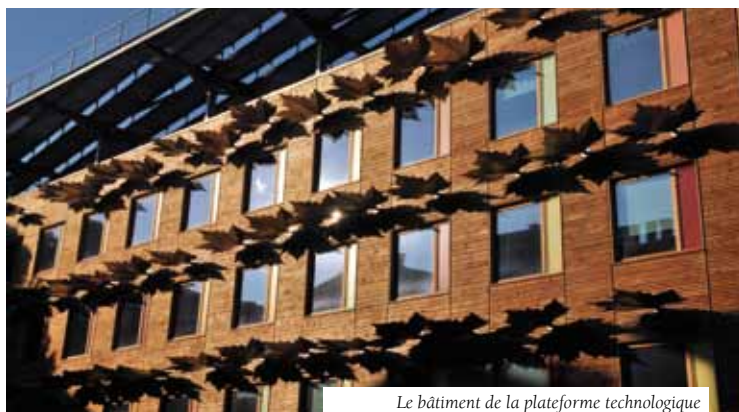
Le bâtiment de la plateforme technologique
